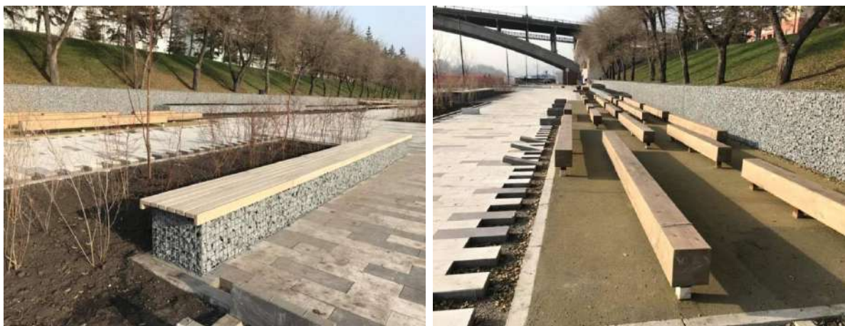
Рисунок 2 - Габионы на набережной Красноярска
